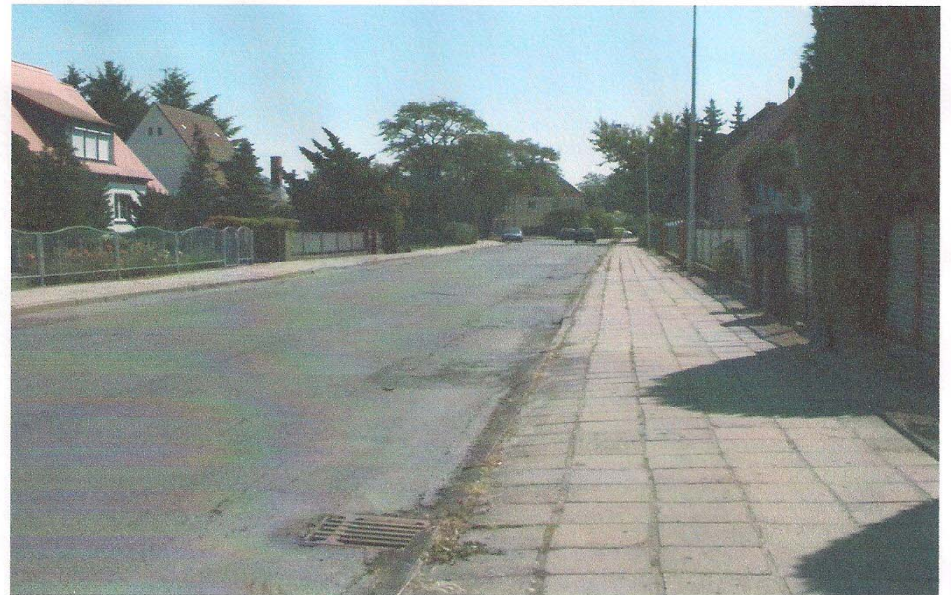
Benutzung der Straße für Rollstuhlfahrer nur auf der Fahrbahn möglich
