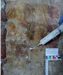
Hinterfüllung von Putzhohlstellen mittels Injektion
