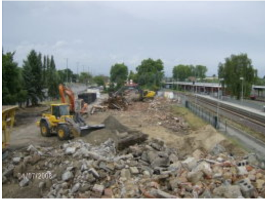
Rückbau Standort „Alter Stadtbahnhof“
