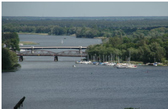
Immer wieder beeindruckend: Blick vom Wasserturm
