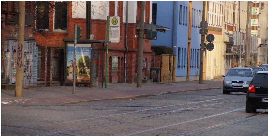
Foto: Stadtauswärtige Straßenbahnhaltestelle Fouquéstraße im Bestand
