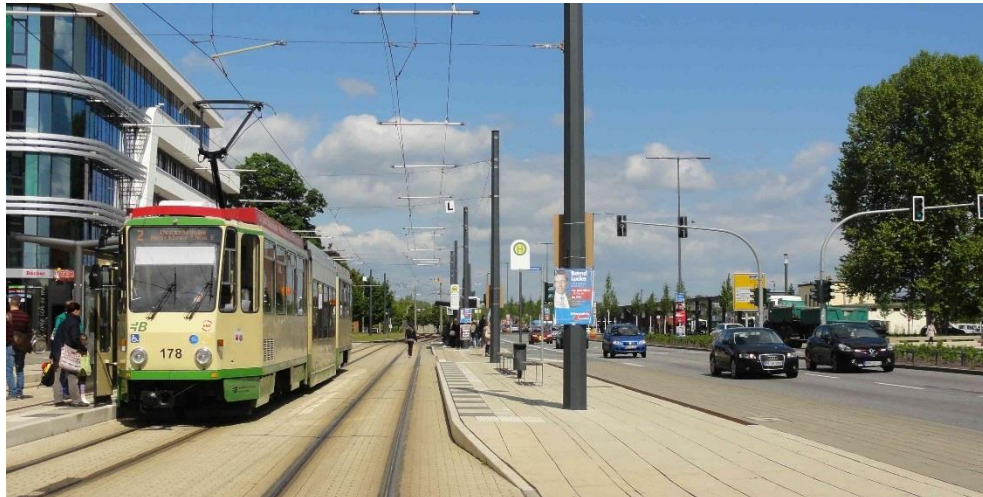
Foto: Straßenbahnhaltestelle Hauptbahnhof mit Fußgängerquerung zum Bahnhof
