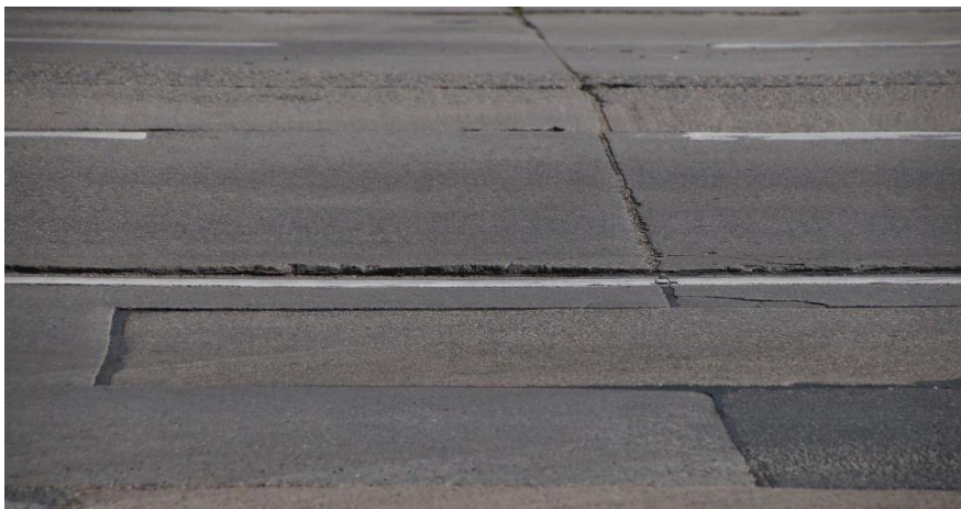
Foto: Fahrbahnbelag des Stadtrings auf Höhe Wilhelmsdorfer Straße
