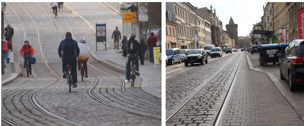
Foto: Links: Radfahrende auf Kopfsteinpflaster (Hauptstraße), Rechts: Streifen geschnittenes Pflaster (Steinstraße)
