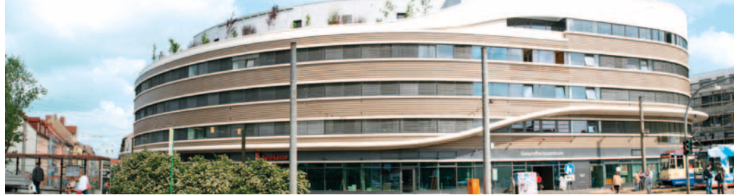
◀ Gesundheitszentrum am Hauptbahnhof · Galerie im Gesundheitszentrum
