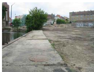
Fischereigelände nach dem Rückbau
