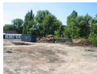
Rückbau ehem. Busbahnhof
