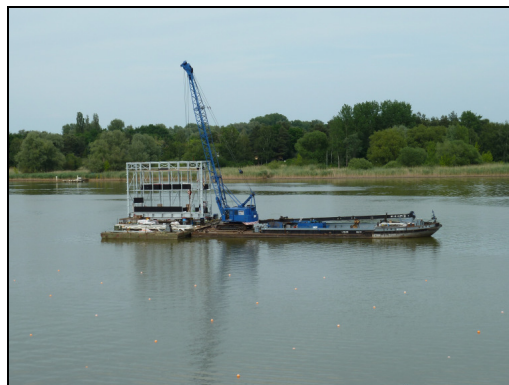
Am neuen Standort mitten im Beetzsee wird die vergrößerte Videowand mit schwerer Technik aufgebaut.
