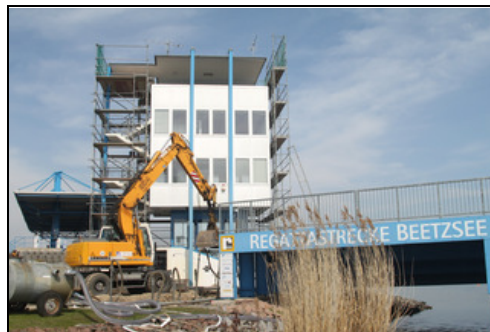
Bevor das Fundament gegossen wurde, war im Frühjahr eine aufwändige Grundwasserabsenkung notwendig.
