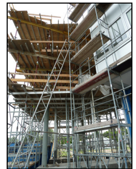
Juni 2010: Der Bau des neuen Turmes schreitet zügig voran.
