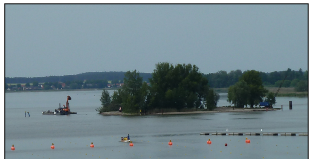
Die „verschobene“ Insel: Links im Bild sind die durch Abbaggerung gewonnenen 27 m für die zusätzlichen Bahnen deutlich erkennbar.
