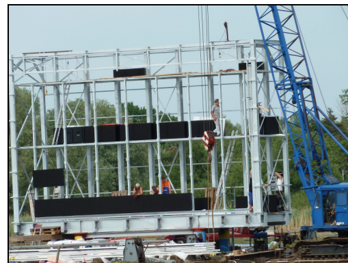
Techniker befestigen die hochmodernen und leistungsfähigen Module der neuen Videoanzeigetafel am 8 x 12 m großen Stahlgerüst.
