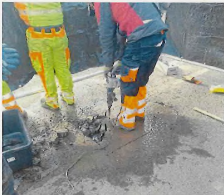
Öffnen der Asphaltfahrbahn
