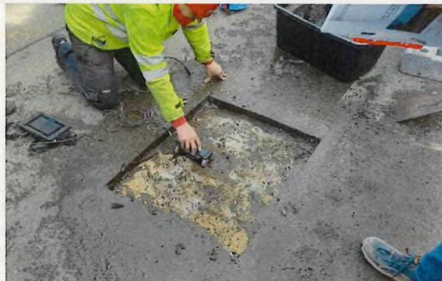
Ortung der Bewehrungsseisen zur Vorbereitung der Stemmarbeiten
