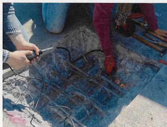
Entnahme eines Spannstahl aus einem Spannglied-Bündel
