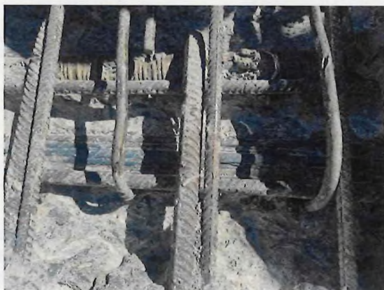
Geöffnetes Spannglied innerhalb des Bewehrungskorbes
