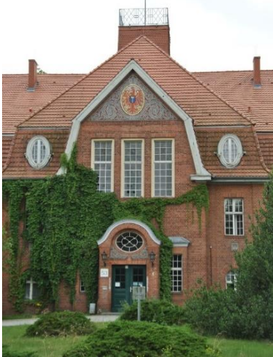
Verwaltungsgebäude der ehemaligen Landeslinik
