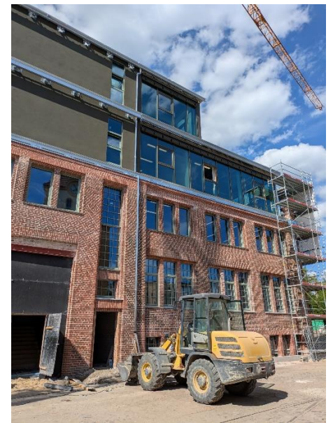
Sanierung des ehem. Elektrizitätswerks
