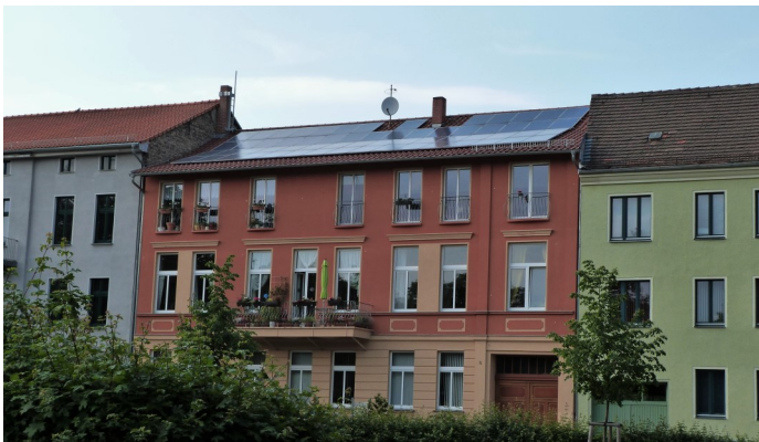
Solaranlage auf dem Dach eines Hauses am Gertrud-Piter-Platz
