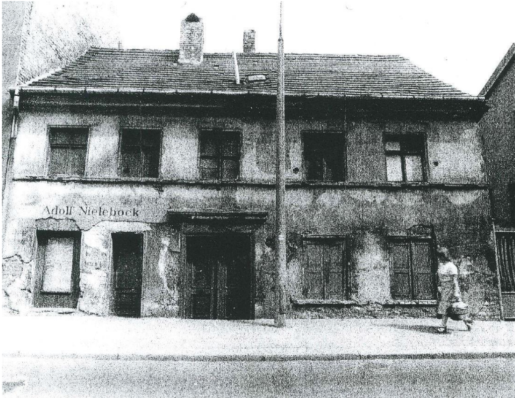
Früheres Wohnhaus Mühlendamm 6 vor dem Abriß
