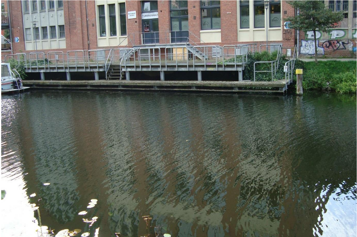
Bootssteganlage – Holzterrasse/Holzbohlen auf Stahlunterkonstruktion; Foto: GLM
