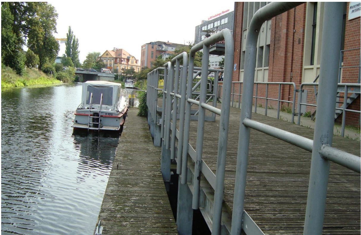
Bootssteganlage – Holzterrasse/Holzbohlen auf Stahlunterkonstruktion; Foto: GLM
