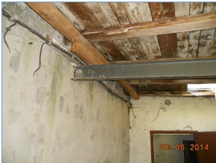
Abbildung 4: Dachkonstruktion aus Brettern und Dachpappe
