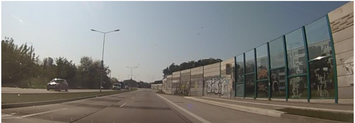
Foto: Lärmschutzwand zur Abschirmung rückwärtiger Bereiche, B 102 Rathenower Landstraße
