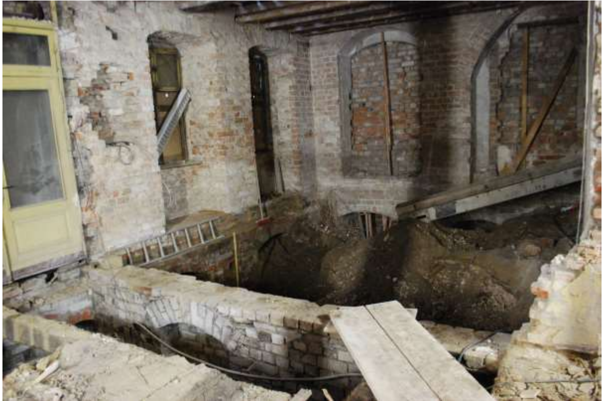
Der verschüttete Keller während der Freilegung 2013. J. Müller
