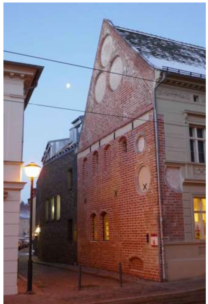
Der sanierte Kernbau mit dem neu errichteten Flügelbau 2015, Blick von der Ritterstraße. J. Müller
