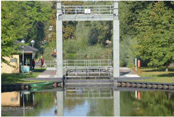
Die Kapazität reichte aber bald nicht mehr aus und 1881 löste dann die Krakauer Vorstadt-schleuse diese Schleuse ab. Die veraltete Kesselschleuse aus Holz wurde durch eine kleinere Schleuse aus Beton und Stahl ersetzt.
